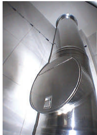
Sichtbarer Einwurf, Türe mit Scharnier, Edelstahl geschliffen
